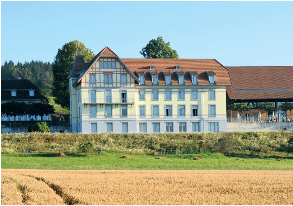
Les bâtiments de la clinique Südhang à Kirchlindach. photo: mäd
